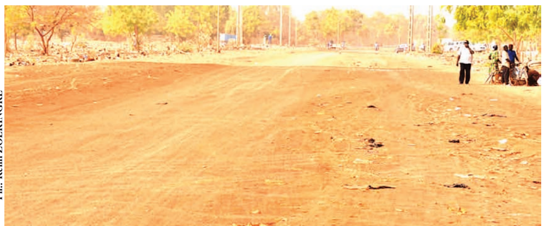
Dans douze mois, la route de Toudbwéogo, prolongement de l'Avenue de la Concorde nationale, devrait faire peau neuve.
