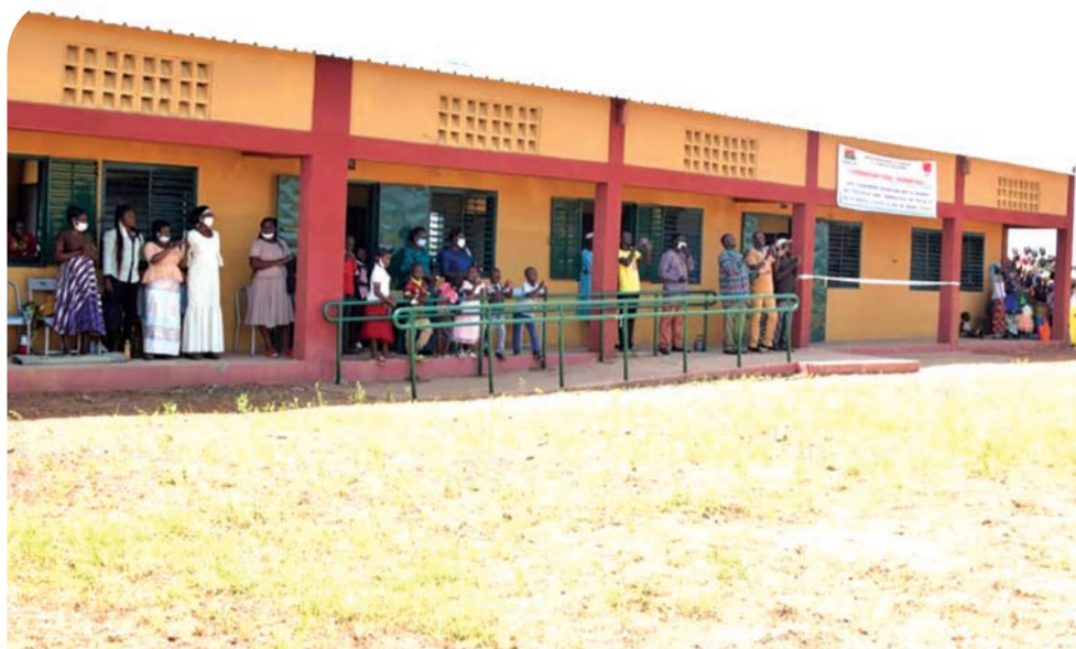
La résorption des écoles sous pailote est l'un des projets phares de la Chine.
